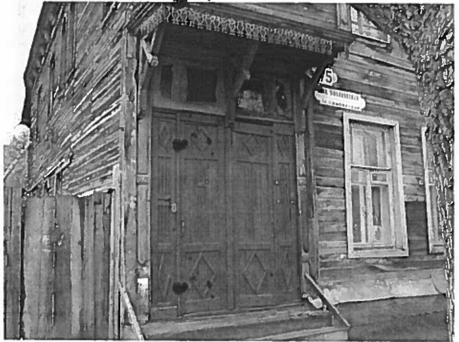
10.08.2014 г., г. Самара, ул. Ульяновская, 75, литер А. Главный фасад. Входная группа.
