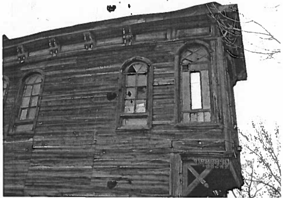
10.08.2014 г., г. Самара, ул. Ульяновская, 75, литер А. Боковой фасад. Эркер.
